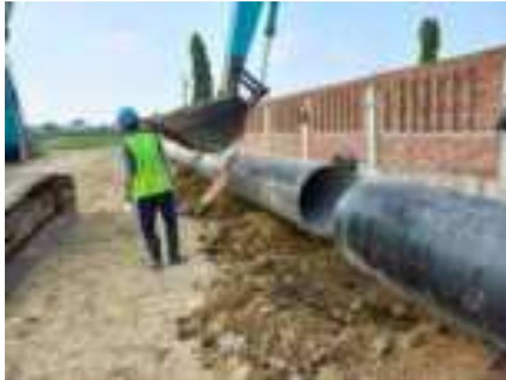
*Gambar 60. Pemasangan Pipa Steel Res.Dagen
