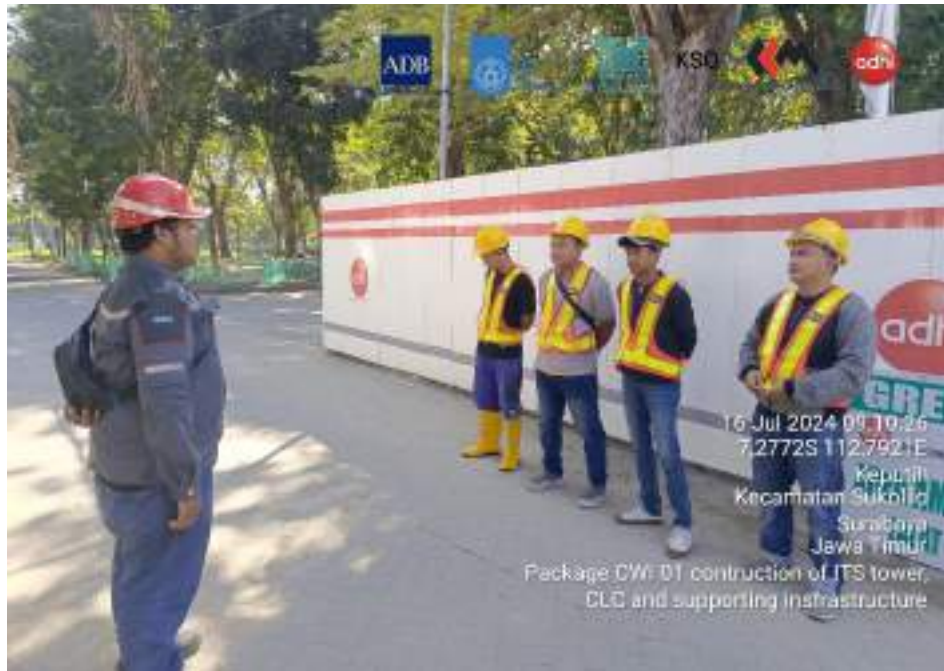
Lampiran 13. Penindakan Kepada pekerja yang melanggar kebijakan K3
